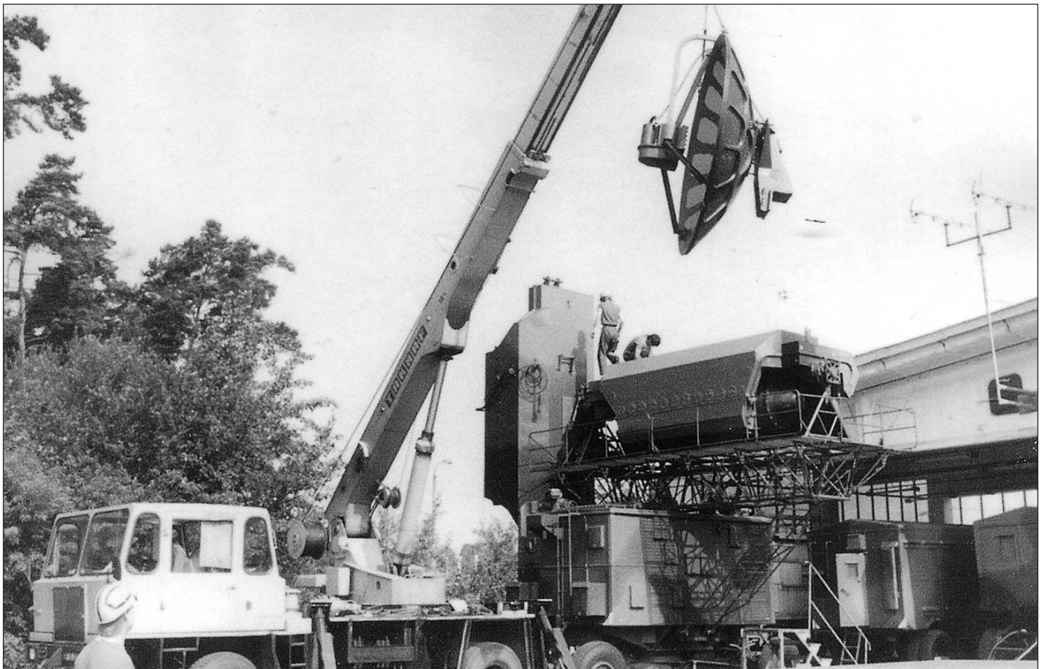
Die letzte Instandsetzung eines „Wolchow“ im IWP (Instandsetzungswerk Pinnow), Juli 1990: Komplex-Nr. 07301
