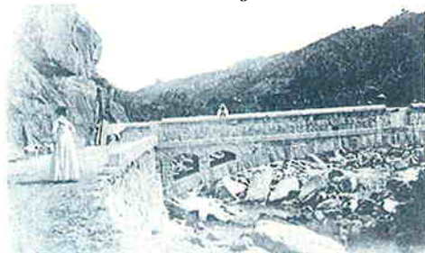
Cäcilienbrücke im Lauschantal.
